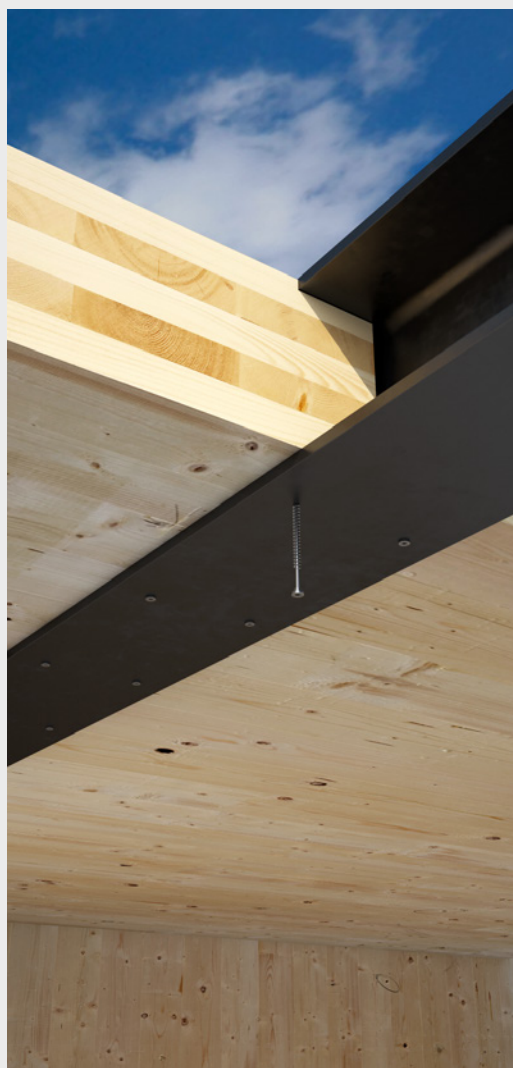
> Verbindung einer gemischten Stahl-Holz-Konstruktion
