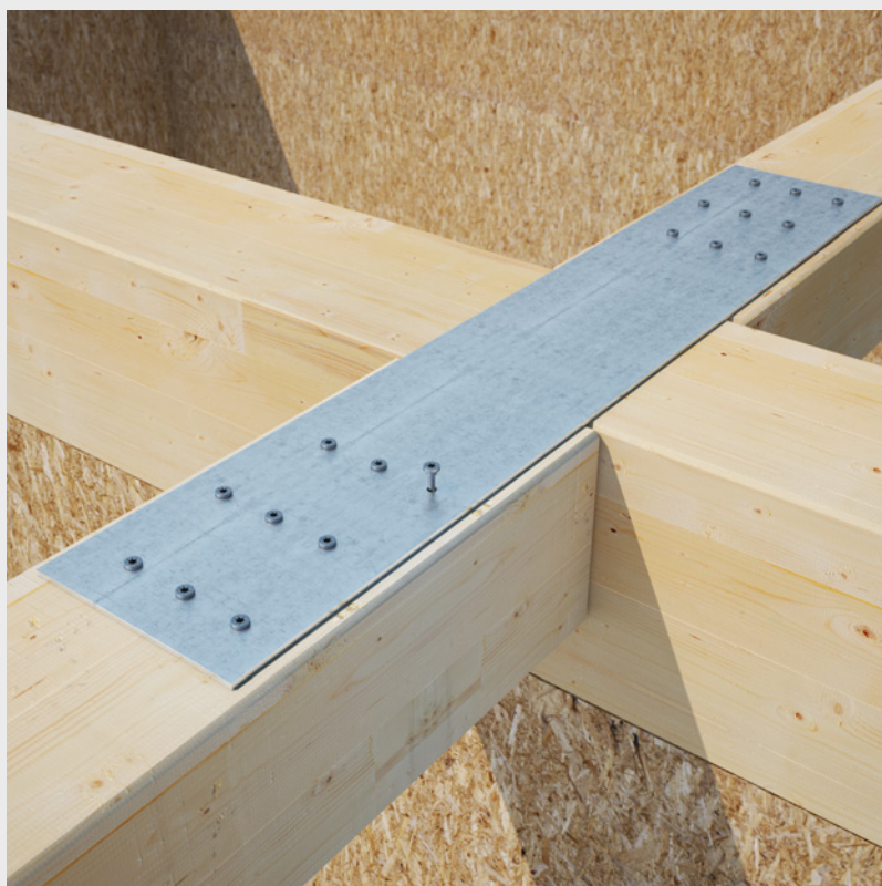
^ Scherverbindung Stahl-Holz
