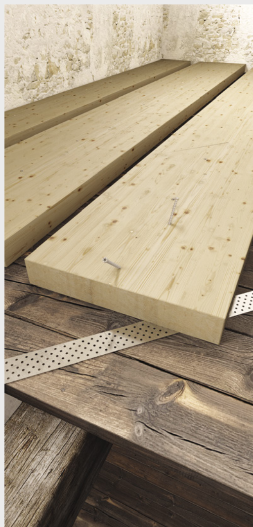
> Restauration de plancher existant en bois avec poutres en lamellé-collé et connecteurs VGZ.
