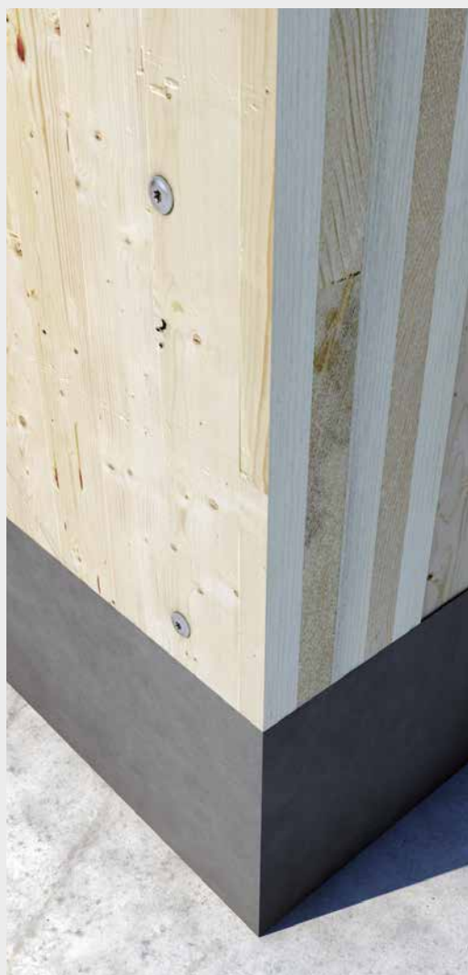
> CLT panelek rögzítése 8 mm átmérőjű TBS csavarokkal.
