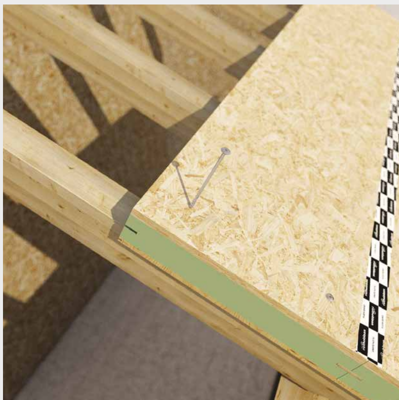
^ SIP panelek rögzítése 8 mm átmérőjű TBS csavarokkal.
