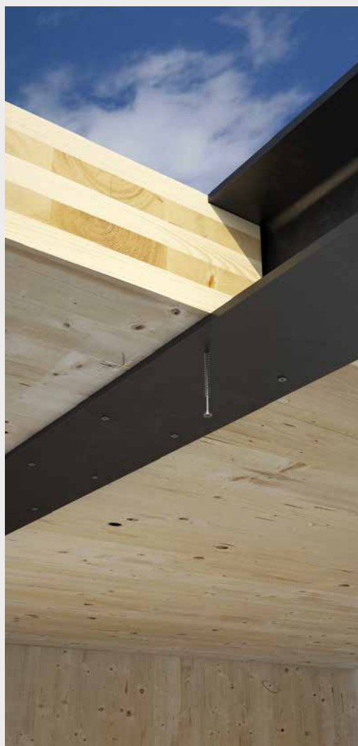
Spoj mešanih struktur jeklo-les >
