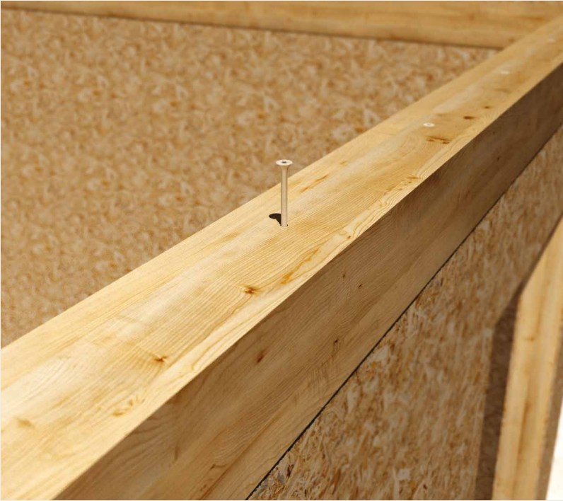
^ 框架结构的平台横梁的紧固。
