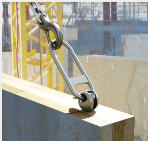
↑ Sustav za podizanje i transport pomoću spoja WASP i vijka VGS.
