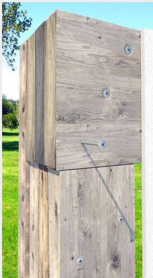
Upevnění 3-vrstvých trámů Multi-ply se sádkartonovou výztuží.
