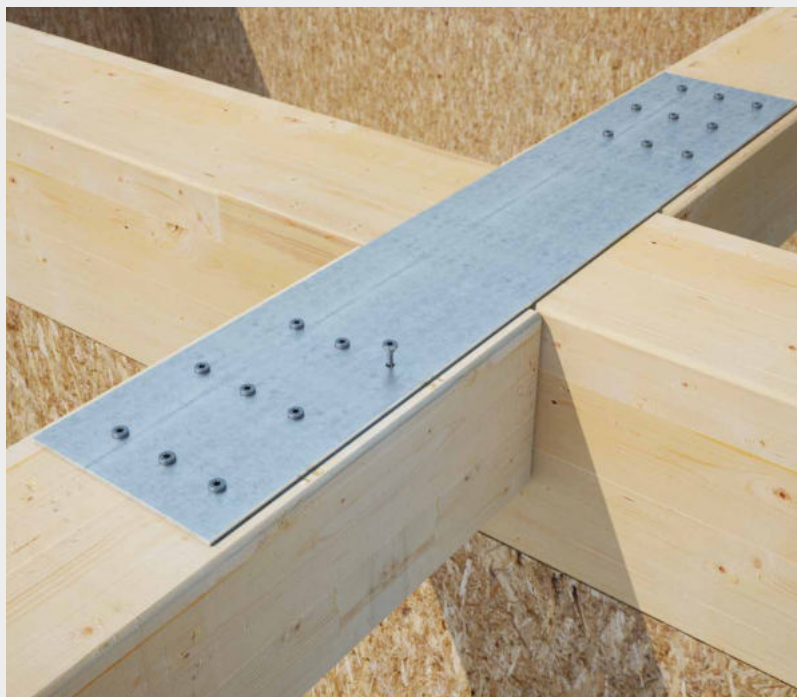
Σύνδεση κοπής χάλυβα-ξύλου
