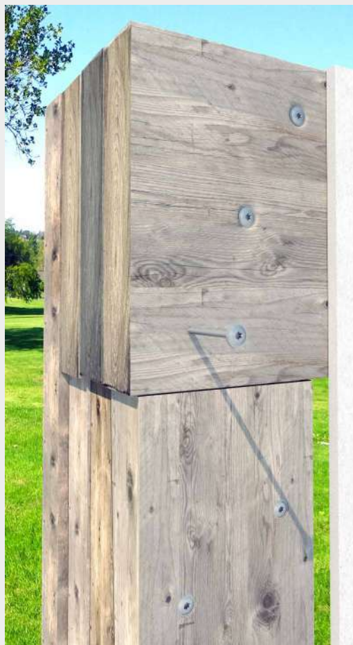
> Bevestiging van multiplexbalken in een buitenomgeving toepassing.
