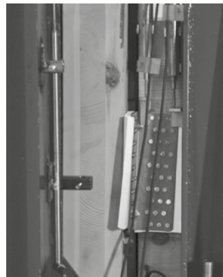
Δείγματα δοκιμής: πάνελ CLT γωνία TITAN TTF200
