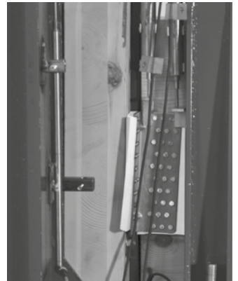
Δείγματα δοκιμής: πάνελ CLT γωνία TITAN TTF200
