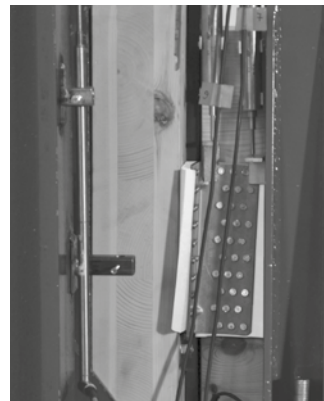
試験片: CLT パネル TITAN TTF200 アングルブラケット
