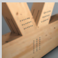
Sistema WS per giunzioni acciaio-legno
