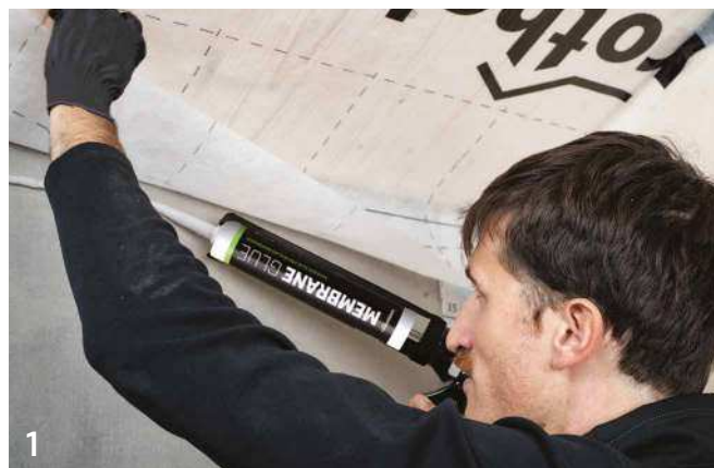
УСТАНОВКА МЕМБРАНЫ НА БЕТОННОЕ ОСНОВАНИЕ
