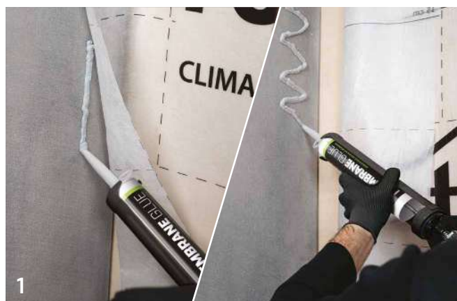
УСТАНОВКА МЕМБРАНЫ НА СТЕНУ - БЕТОН
