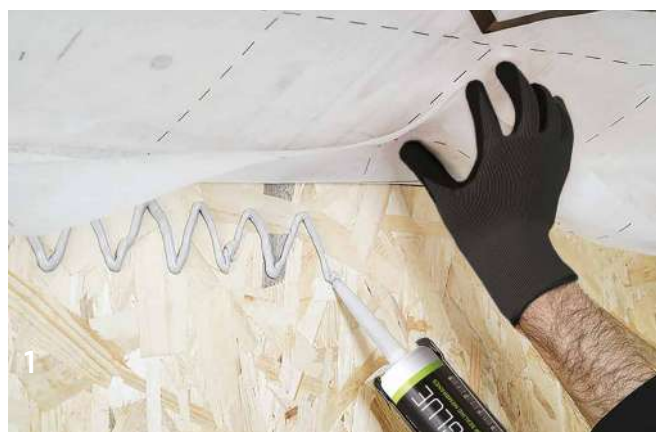
УСТАНОВКА МЕМБРАНЫ НА OSB ОСНОВАНИЕ
