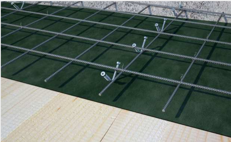
^ CLT 面板上的木-混凝土复合楼板，采用 45°螺钉单排排列。 ^ 木-混凝土复合楼板，采用 30°螺钉双排排列。
