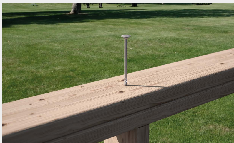
^ Mocowanie Wood Trusses w otoczeniu zewnętrznym.
