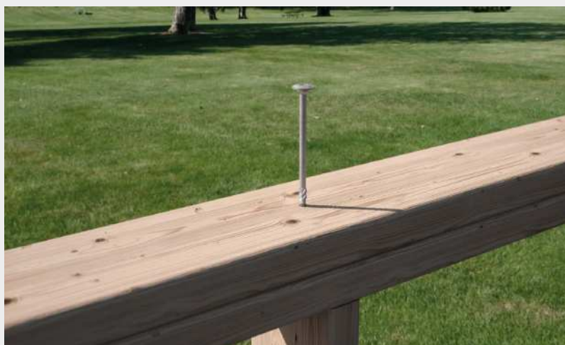
^ Mocowanie Wood Trusses w otoczeniu zewnętrznym.
