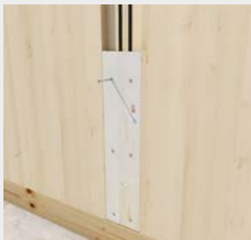
^ CLT panelek rögzítése 6 mm átmérőjű HBS csavarokkal.
