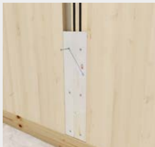
Fixovanie stien z CLT pomocou skrutiek HBS s priemerom 6 mm.
