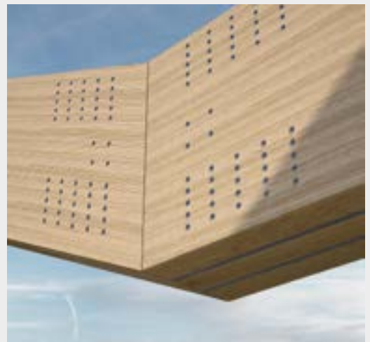
Trevägsförband med dubbel intern platta (LVL).
