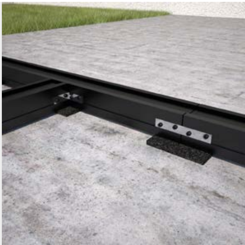
Stabilizarea profilurilor ALUTERRA50 cu plăci din oțel inoxidabil și șuruburi KKA.
