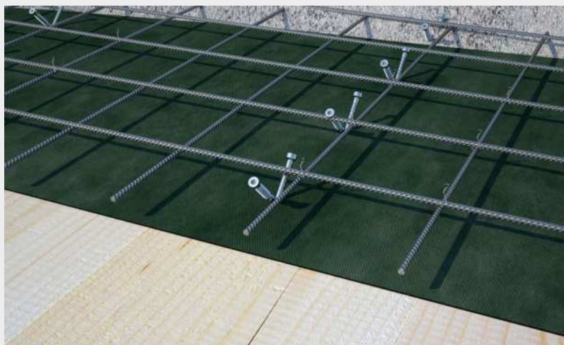
^ Puu-betoniyhdistelattia CLT-levyllä 45° liittimillä asennettuna yhteen riviin.
