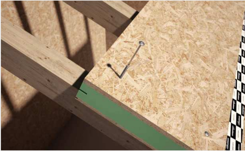
8mm 직경의 TBS 스크류로 SIP 패널을 고정합니다.
