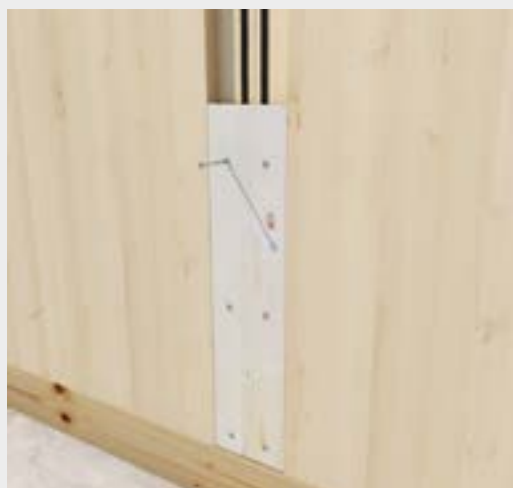
Bevestiging wanden van CLT met schroeven HBS diameter 6 mm.
