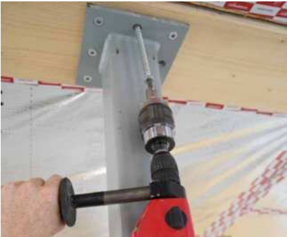
Beim Eindrehen rastet der TORQUE LIMITER beim eingestellten Drehmomentwert aus.
