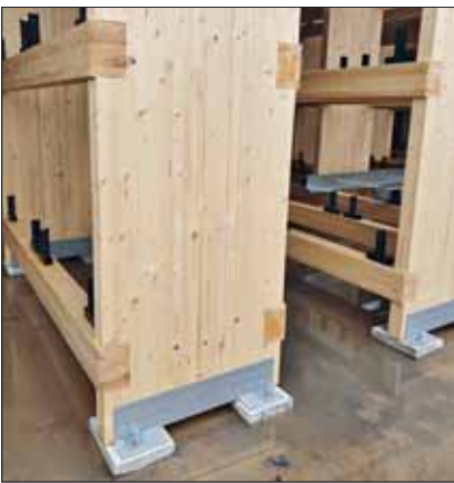
Verankerung der Brettschichtholz-Regale
