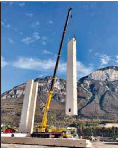
Aufrichten eines Aussteifungsturms
