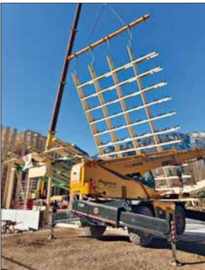
Auf dem Bau vormontierter Regalblock
