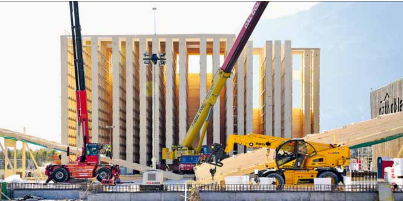
Ein Überblick über den Baustellenablauf: Auf der 60 cm dicken Bodenplatte im Vordergrund die zwei Schablonen zur Vormontage der Regalblöcke, rechts mit eingelegten Stehern. Im Hintergrund die fortschreitende Montage der Regalblöcke, die an die zuerst aufgerichteten Aussteifungstürme (Bild rechts oben) angeschlossen werden. Rückseitig und links zu sehen ist die Aussteifung der Konstruktion mit den Außenwänden aus Brettspertholz. Fotos: Kaufmann Bausysteme
