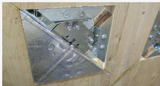
Montaggio dei componenti X-SEAL
