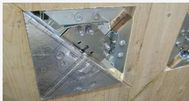
Montage des composants X-SEAL
