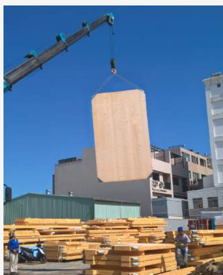
transporte de paneles
