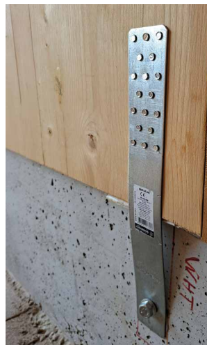
Piastre di fissaggio installate non correttamente: mancato rispetto delle distanze dai bordi o presenza di un cordolo irregolare, che impedisce il corretto inserimento di viti e tasselli e può causare la deformazione della piastra di connessione.
