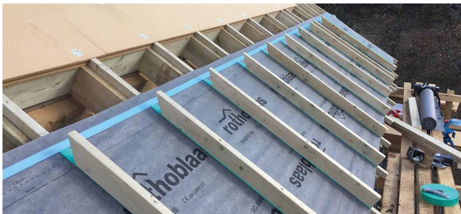
Membrana installata correttamente a partire dal basso, con continuità dello strato assicurata mediante nastri e sigillatura del chiodo.
