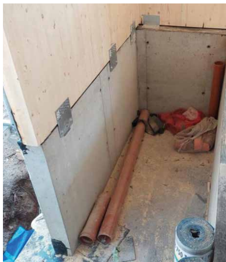
Struttura in legno rialzata mediante cordolo. Impermeabilizzazione applicata sulla base cementizia e parete perfettamente allineata a filo interno.
