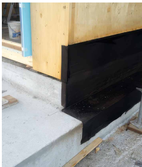
Parete in legno rialzata mediante cordolo, uso di isolante resistente all'umidità nella parte inferiore.
