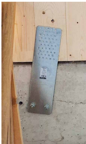
Piastre di fissaggio installate non correttamente: mancato rispetto delle distanze dai bordi o presenza di un cordolo irregolare, che impedisce il corretto inserimento di viti e tasselli e può causare la deformazione della piastra di connessione.
