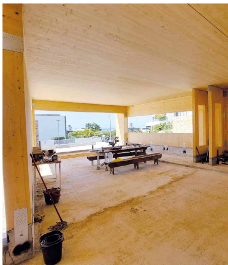
Pareti in legno perimetrali e interne rialzate, cordolo in calcestruzzo sagomato in corrispondenza delle porte.
