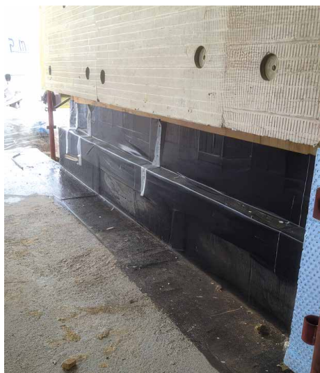
Parete in legno rialzata mediante cordolo, uso di isolante resistente all'umidità nella parte inferiore.
