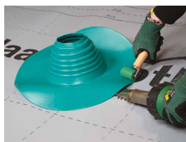
Sigillatura con aria calda.
