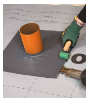
Sigillatura con aria calda.
