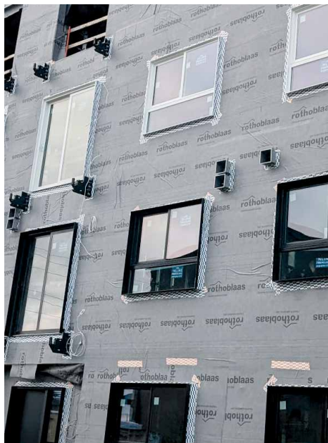
Membrana adesiva nastrata nei punti critici.
