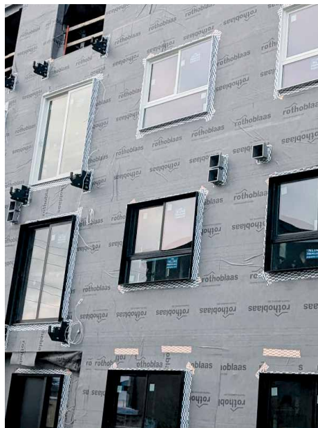
Membrane adhésive collée aux points critiques.
