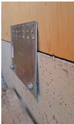
Plaques de fixation mal posées : non-respect des distances par rapport aux bords ou présence d'une bordure irrégulière, qui empêche l'insertion correcte des vis et des chevilles et peut entraîner la déformation de la plaque de fixation.
