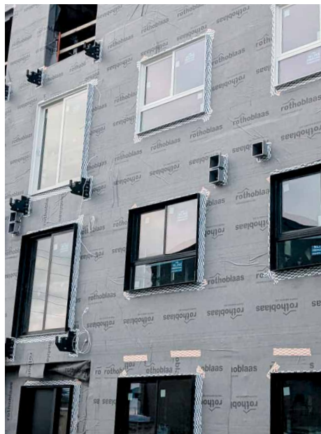
Lámina adhesiva encintada en los puntos críticos.
