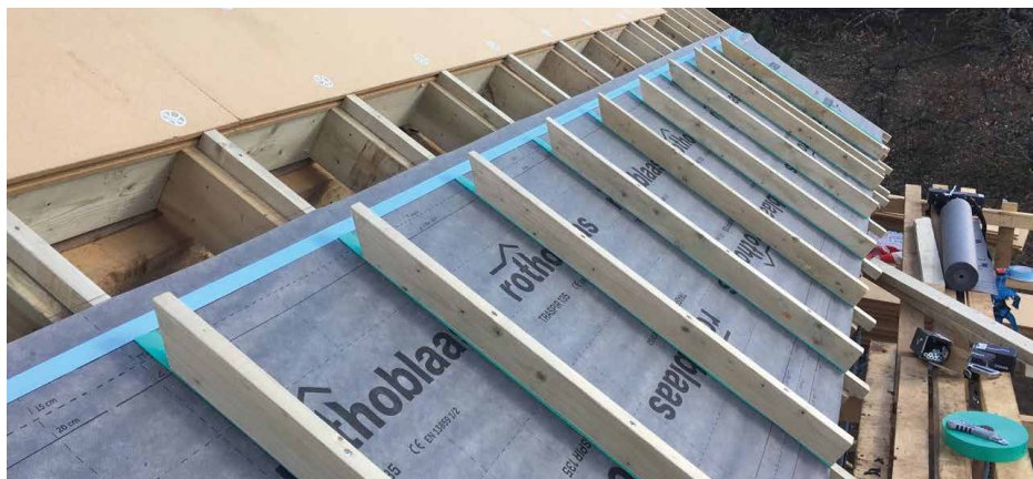
Lámina instalada correctamente a partir de la parte inferior, con continuidad de la capa asegurada mediante cintas y sellado del clavo.
