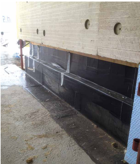
Mittels Aufkantung erhöhte Holzwand, Verwendung von feuchtigkeitsbeständigem Dämmstoff im unteren Teil.
