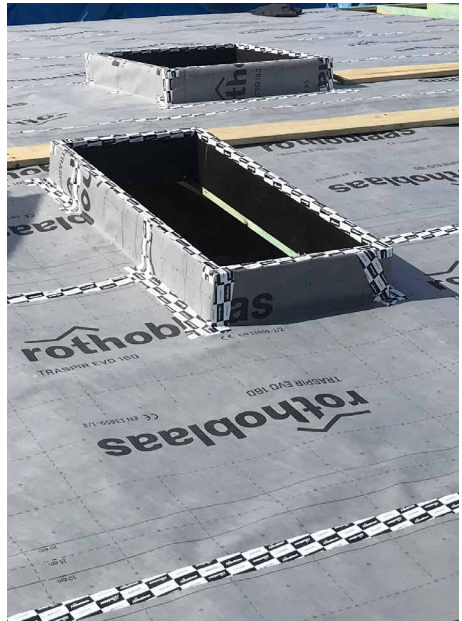
Auch im Fensterbereich korrekt abgeklebte Bahn.
