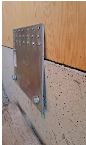
Nicht fachgerecht montierte Befestigungsplatten: Nichteinhaltung der Randabstände oder Vorliegen einer unregelmäßigen Aufkantung, was das korrekte Eindrehen von Schrauben und Setzen von Dübeln verhindert und zur Verformung der Verbindungsplatte führen kann.
