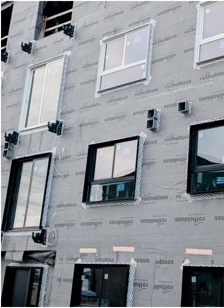
An den kritischen Punkten abgeklebte Bauzeitenabdichtung.
