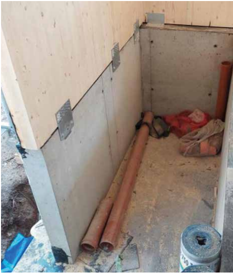
Mittels Aufkantung erhöhte Holzkonstruktion. Auf dem Sockel aufgebrachte Bauabdichtung und perfekt innenbündig ausgerichtete Wand.
