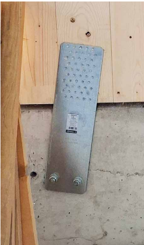
Nicht fachgerecht montierte Befestigungsplatten: Nichteinhaltung der Randabstände oder Vorliegen einer unregelmäßigen Aufkantung, was das korrekte Eindrehen von Schrauben und Setzen von Dübeln verhindert und zur Verformung der Verbindungsplatte führen kann.
