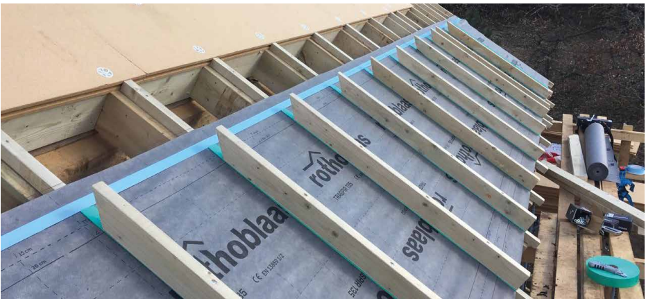
Korrekt von unten nach oben verlegte Bahn, deren Überlappungen durch Klebebänder und Nageldichtung sichergestellt ist.
