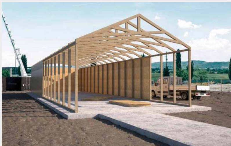
Fissaggio di Wood Trusses in ambiente esterno.
