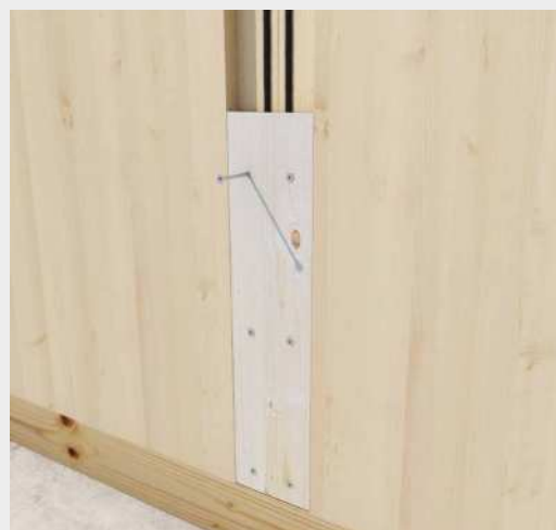
^ Befestigung von BSP-Wänden mit 6 mm HBS.
