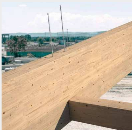
Renfort orthogonal par rapport à la fibre pour charge suspendue due à l'assemblage poutre principale - secondaire.
