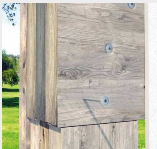
^ Fijación de vigas Multi-ply.
