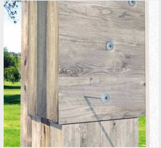
多层梁 Multi-ply 紧固。
