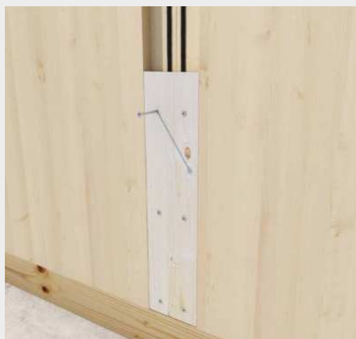
↑ Mocowane ścian konstrukcji CLT wkrętami HBS o średnicy 6 mm.
