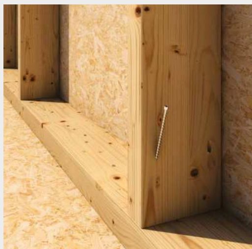
^ Montaż słupków lekkich konstrukcji ramowych za pomocą VGZ EVO Ø5 mm.
