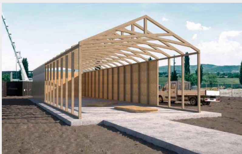
^ Mocowanie Wood Trusses w otoczeniu zewnętrznym.
