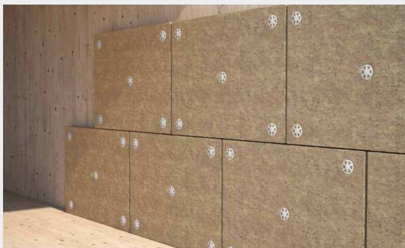
^ Pričvrščivanje izolacijskih panel-ploča za zid s THERMOWASHER i HBS promjer 8 mm.
