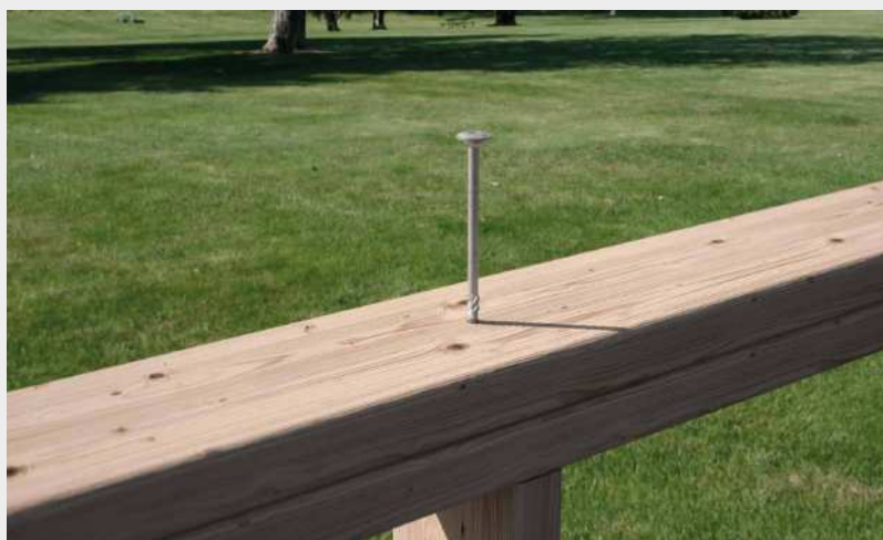
^ Kattoristikoiden kiinnitykset ulkotiloissa.
