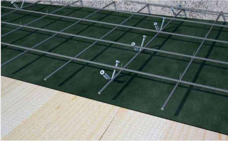
45° 커넥터가 일렬로 배열되어 있는 CLT 패널의 합성 목재-콘크리트 바닥.
