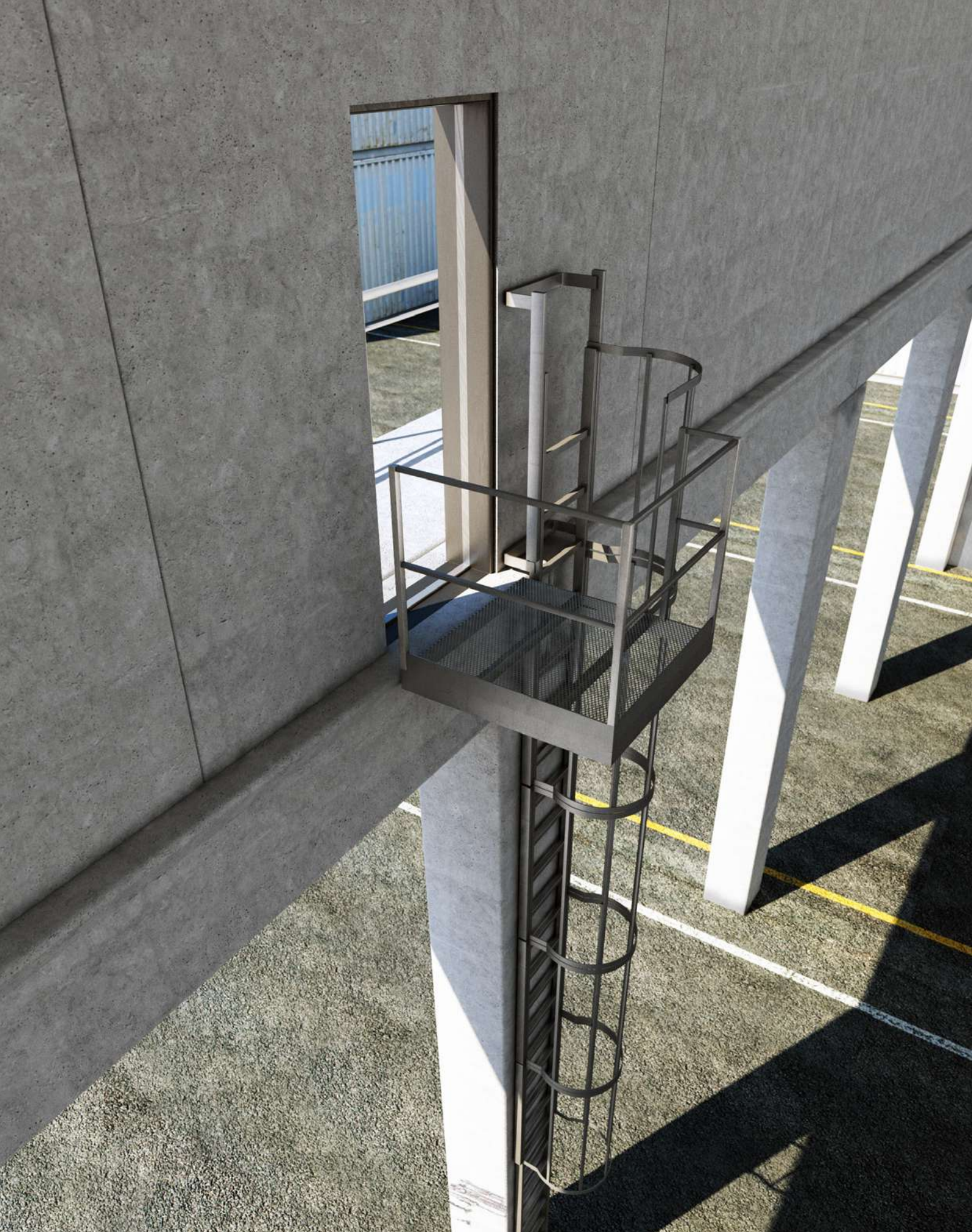
Drabina z klatką bezpieczeństwa z boczną platformą do schodzenia
