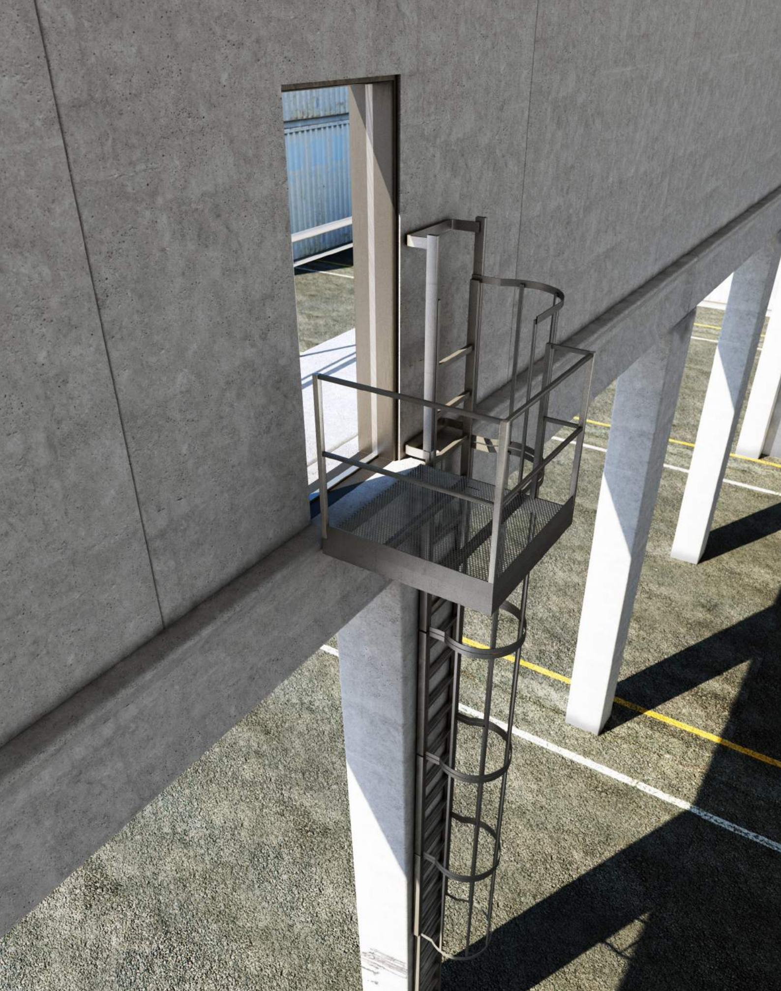
Leiter mit Rückenschutz und seitlicher Austiegsplattform.
