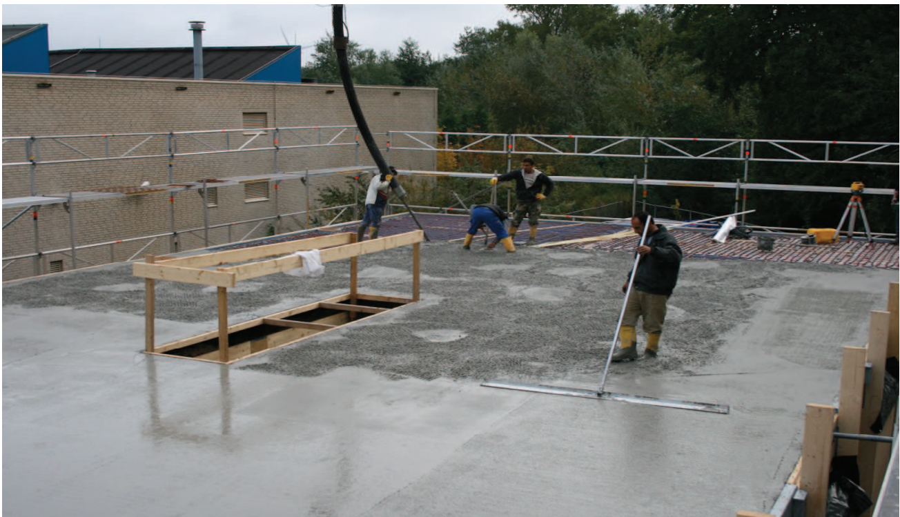
Holzbetonverbundsystem, Raadschelders Bouwadvies, NL
