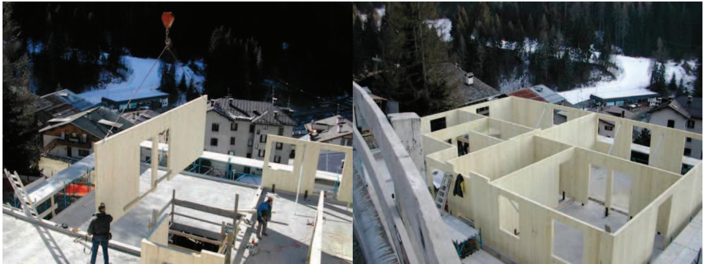
Vorgefertigte Elementen, Kurze Bauzeit der Tragkonstruktion
