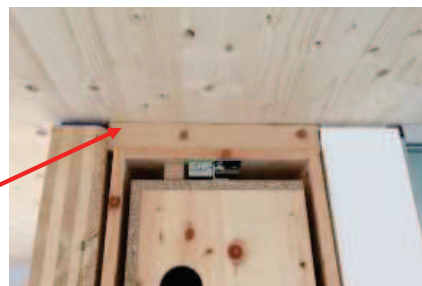
Schalltechnisch entkoppelter Anschluss mittels Schubnocken
