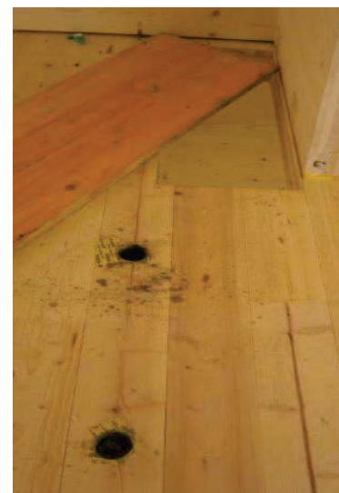
Blick auf Decke im Obergeschoss, Bohrlöcher für Schubnocken
