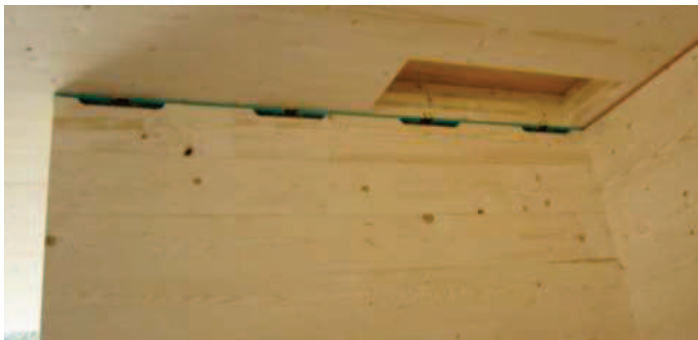
Schalltechnisch entkoppelter Anschluss mittels Schubnocken
