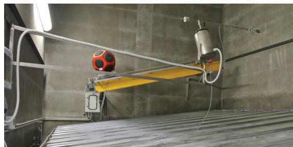
1. attēls: parauga attēls, emitējošā telpa
