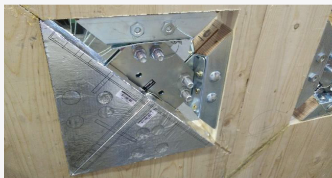
Montage des composants X-SEAL
